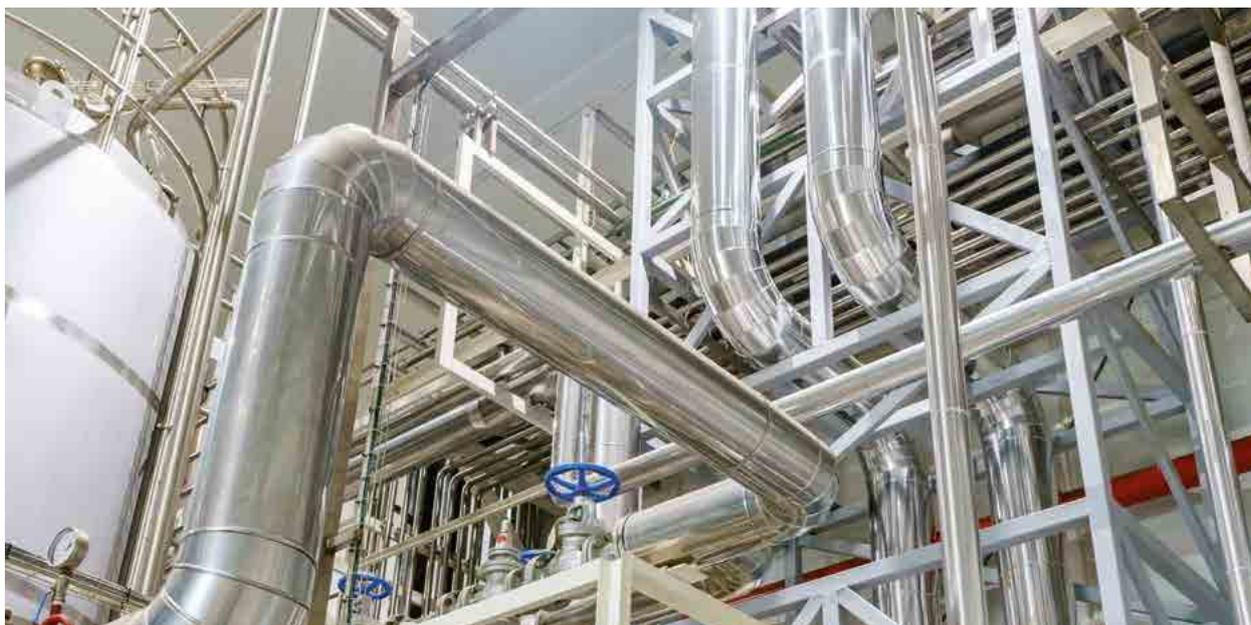
Ogni linea di distribuzione è dotata di valvola di scarico sovrappressione conforme alle direttive 97/23/CE "PED" come prescritto dalla UNI EN961, posta a protezione della tubazione e delle apparecchiature a valle del sistema di decompressione di primo stadio.
